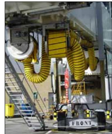
Les enrouleurs de gaines de ventilation préconditionnée (PCA), montés sur une base orientable tournant librement, sont installés inversés sur des passerelles d'embarquement dans le but de refroidir et/ou de réchauffer les cabines passagers d'avions. Ces enrouleurs à actionnement manuel ou motorisé sont disponibles avec têtes pleines ou à rayons. Les enrouleurs motorisés sont complets avec commutateurs de proximité et butée mécanique.
